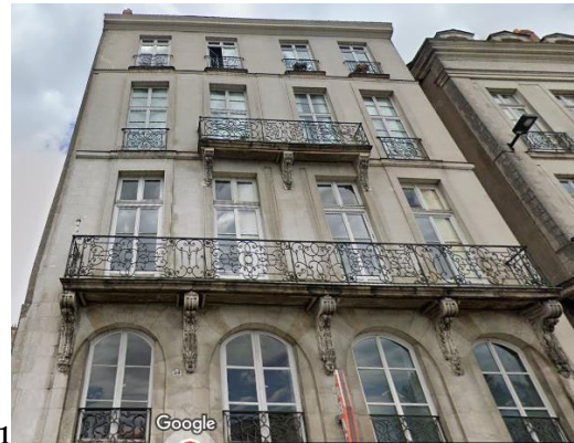
54 quai de La Fosse à Nantes
