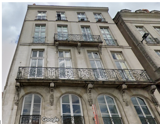
54 quai de La Fosse à Nantes
